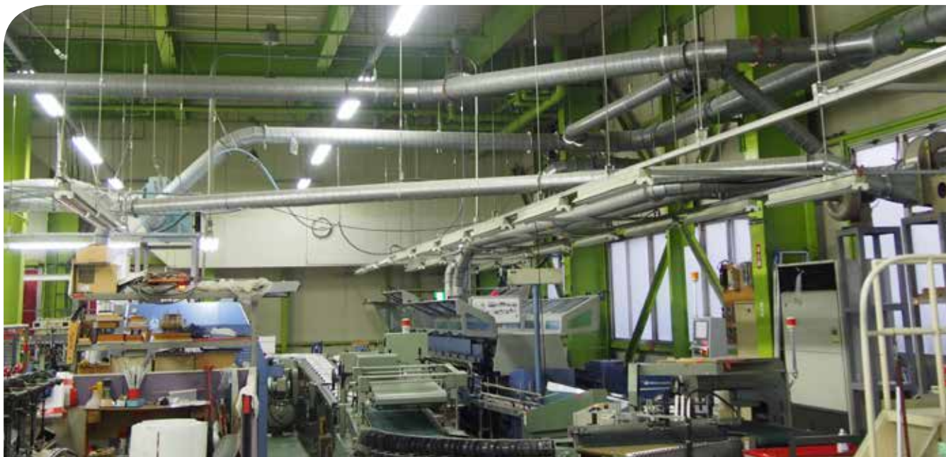
株式会社小島製本 岩槻工場内の断裁機の一部
